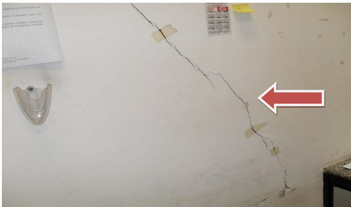
**FIGURA 1.18.** Parede da sala do analisador TOC com rachadura
