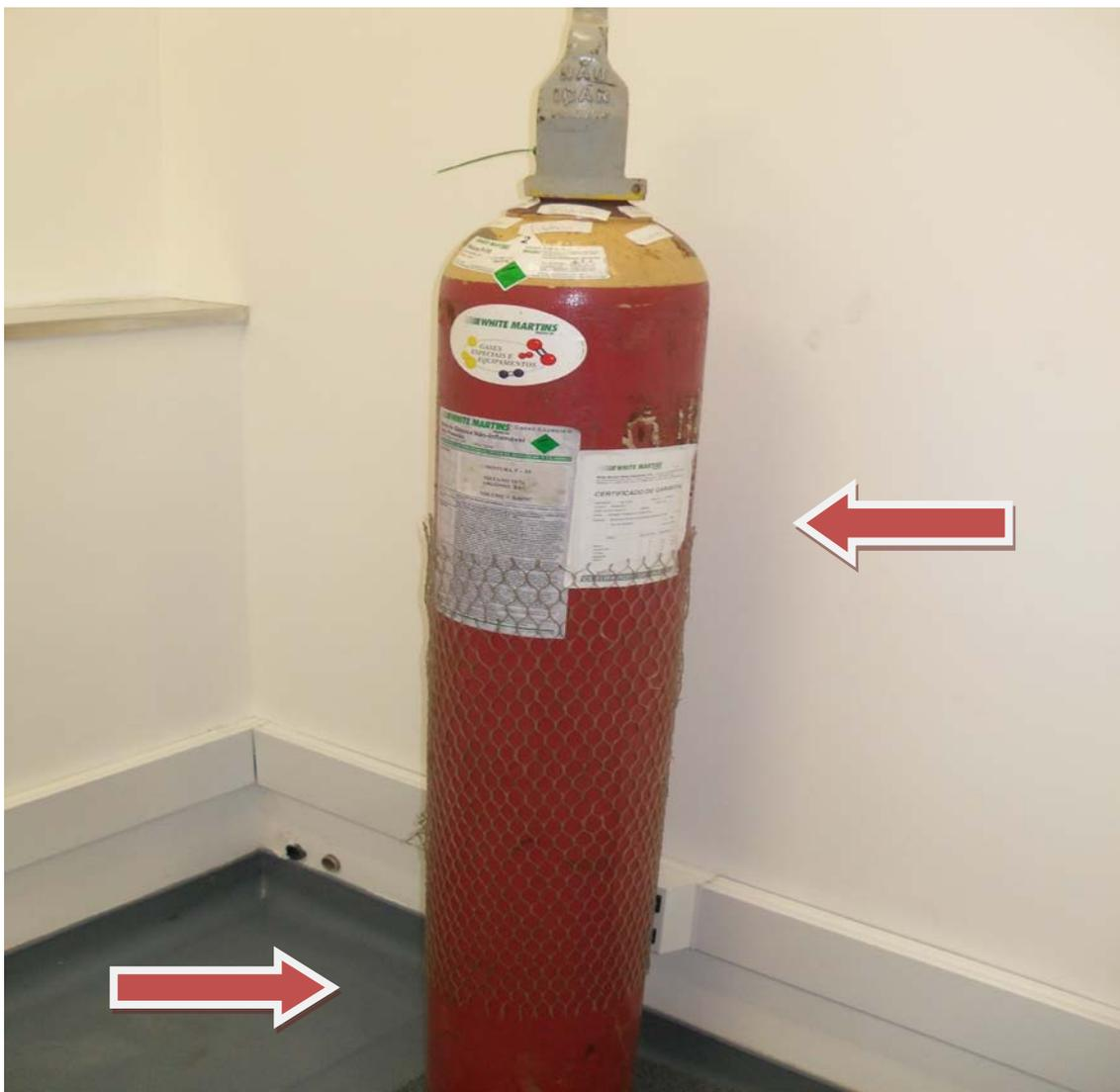
**FIGURA 1.20** Cilindro com gás sem delimitação de área, sinalização e fixação
