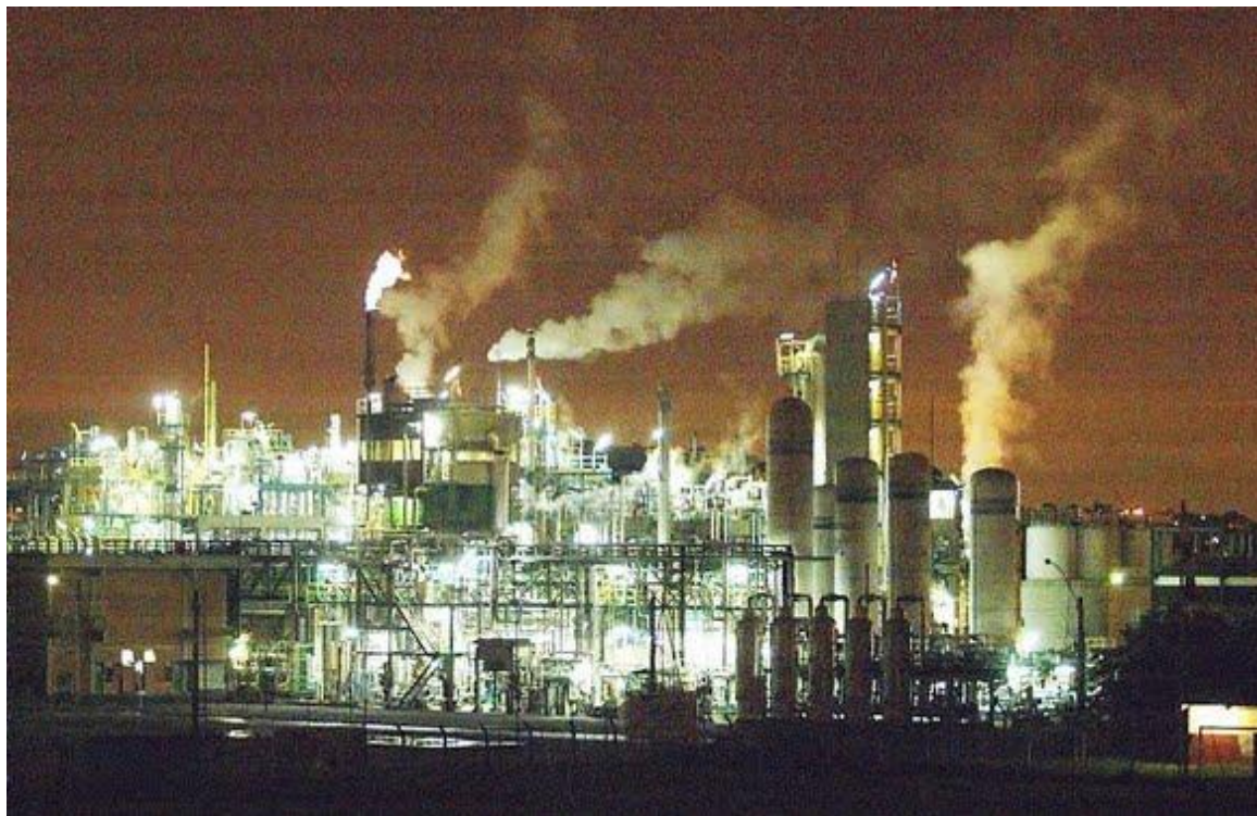
Figura 39 - Fábrica da Bayer do Brasil em Belford Roxo Fonte: FONTE: Blog Belford Roxo por Eufrásio Pereira. Acesso: http://sites.google.com/site/eufrasiopereira2010/belford-roxo/industrias-em-belford-roxo , em 21/06/2011.
