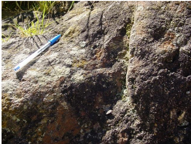
Figura 3.7 Maciço de rocha altamente intemperizada. Vista 1. Próximo ao Campo de Futebol.
