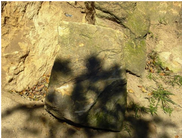
Figura 3.6 Maciço de rocha levemente intemperizada. Vista 2. Rua Oswaldo Seabra.
