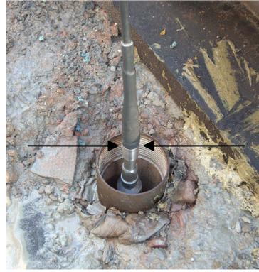
**Figura 25** – Alinhamento da “cabeça” do perfilador com a boca do boca do poço.
