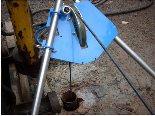
**Figura 24** – Detalhe da utilização do tripé na boca do poço.
