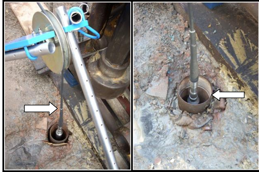
Figura 35- Vista da boca do poço, com revestimento aparente. Nota-se nas setas o que pode servir como referencial para o ponto zero do perfil
