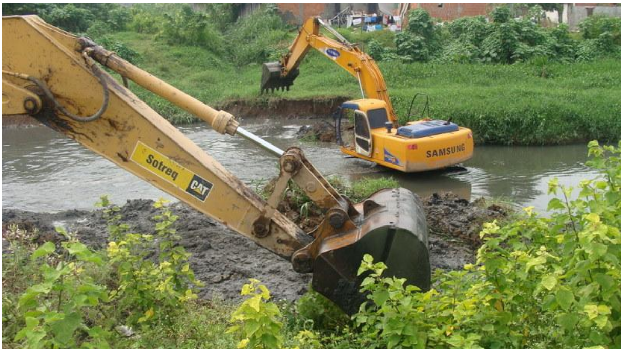
Figura 1.1 – Dragas removendo sedimentos do leito e das margens do Rio Botas.
