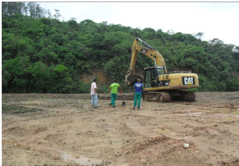
Figura 4.3 – Abertura de cava para retirada do material por uma escavadeira (ponto H), com a jazida de onde se extraiu o material de cobertura para a área, ao fundo.
