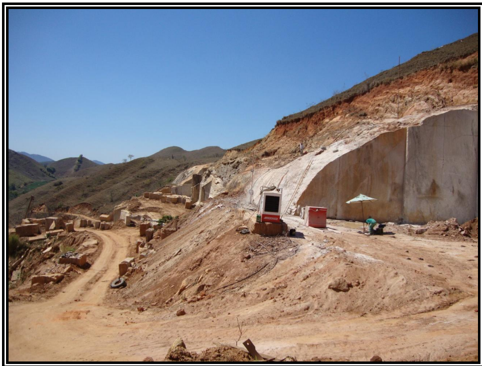
Figura 14: Foto do detalhe do corte com fio diamantado na bancada do maciço rochoso.
