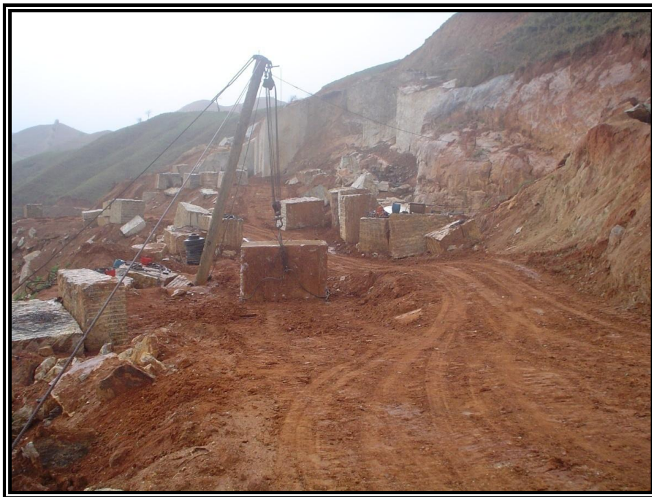
Figura 10: Foto da praça de embarque dos blocos extraídos do maciço rochoso.
