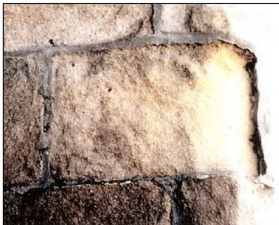
Figura 5: Exemplo da morfologia de alteração desagregação granular. (Henriques et al. , 2005).
