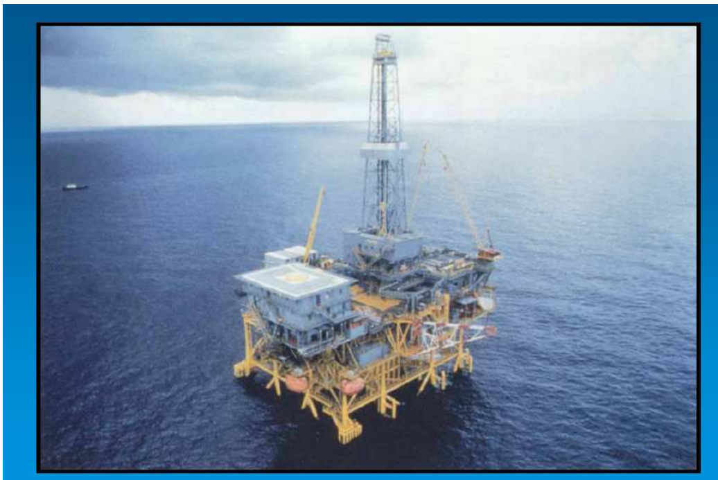
Figura 72- Plataforma fixa de aço (Fonte: Ellwanger, 2006).
