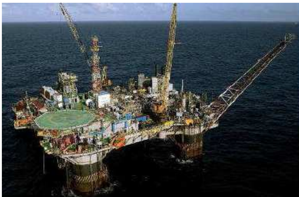
Foto 5 - Começa a operar em 1994 a primeira plataforma semissubmersível (P-18) totalmente desenvolvida pelos técnicos da Petrobras, no Campo de Marlim, na Bacia de Campos (RJ) (Planalto, 2009).
