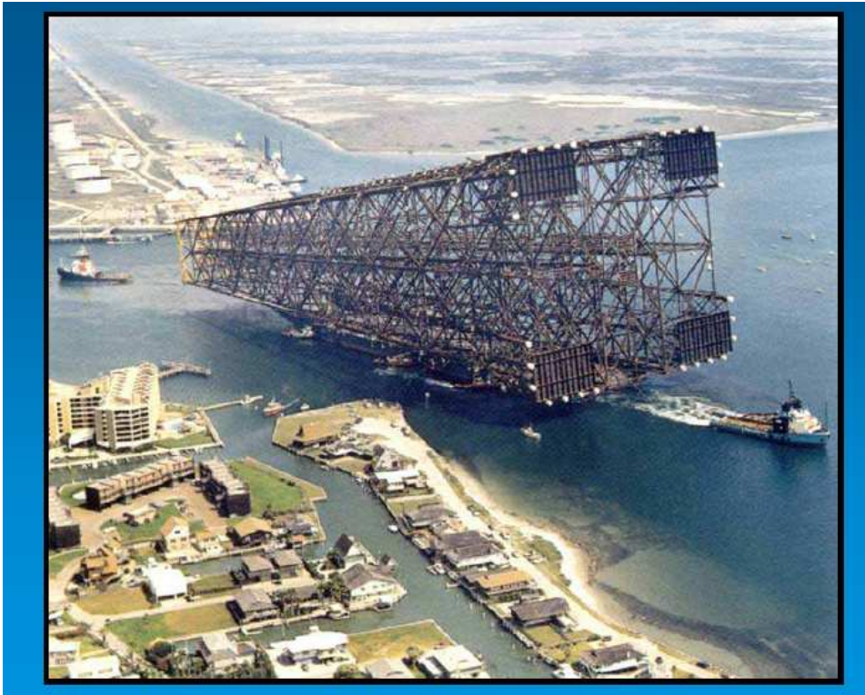
Figura 73 – Plataforma Fixa de aço – visão do transporte da jaqueta (Fonte:Ellwanger, 2006).
